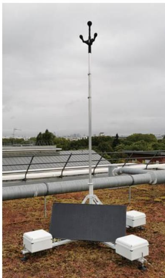
Vue du système de mesure (posé au sol)
