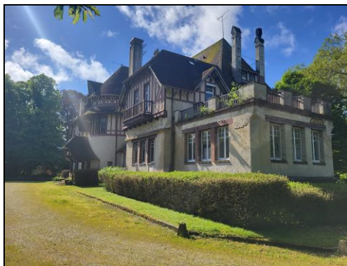
Manoir de Chaubuisson Façade Nord-Est
