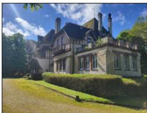
Manoir de Chaubuisson Façade Nord-Est
